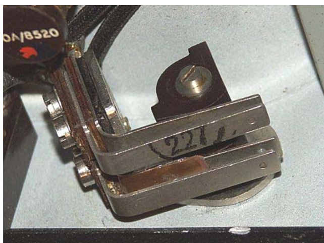
Den reparerade kraftswitchen
