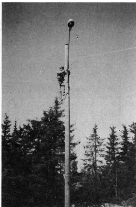
Formannen 5CL utfører antennearbeider iført klatresko.
